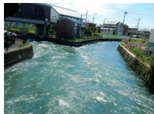
【図 14：増水した際の様子】
